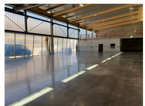
6 Verbundestrich einbauen (verschiedene Stärken)
